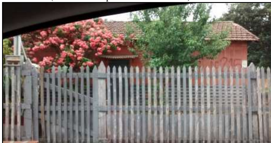
Figura 110 – Bairro (Casas do complexo da Linha férrea) na cidade de São Carlos - SP.
