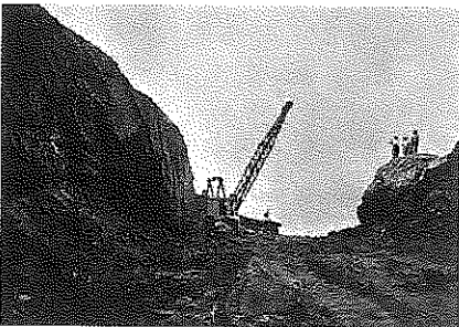
Corte do canal de Ponta Negra. 1950/51
